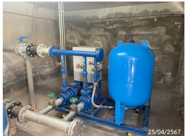
รูปที่ 2-15 Booster Pump
