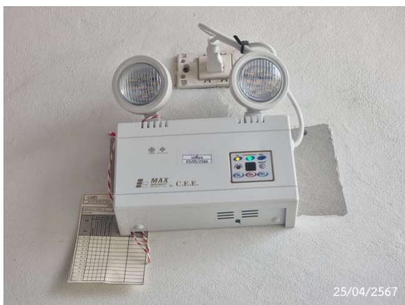
รูปที่ 2-31 ไฟฟ้าส่องสว่างฉุกเฉิน
