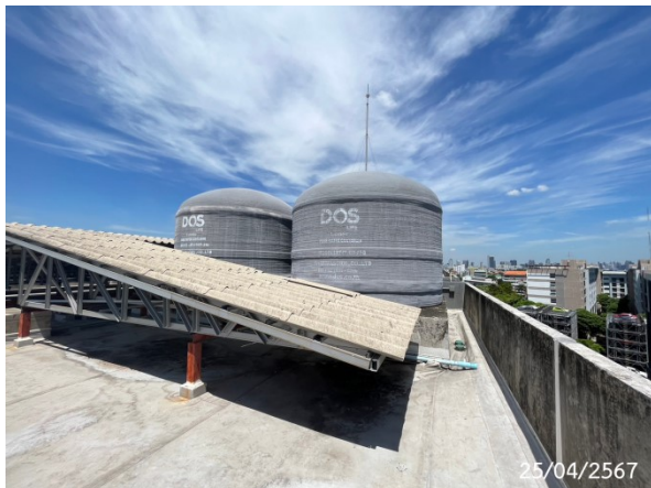
รูปที่ 2-14 ถังเก็บน้ำชั้นดาดฟ้า
