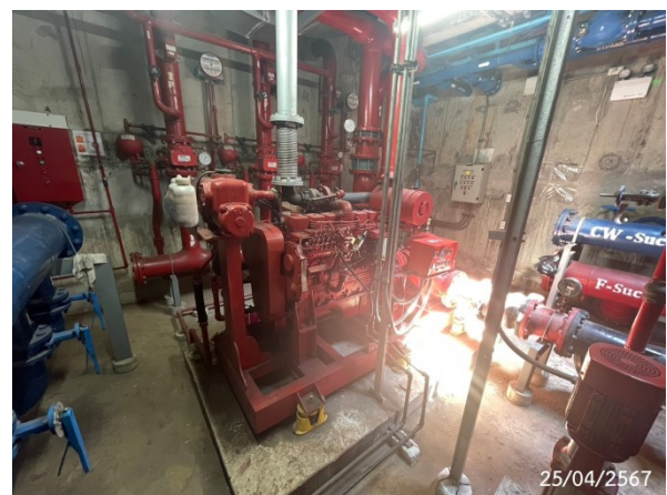
ท่อยืน (Stand Pipe) และเครื่องสูบน้ำดับเพลิง (Fire Pump)
