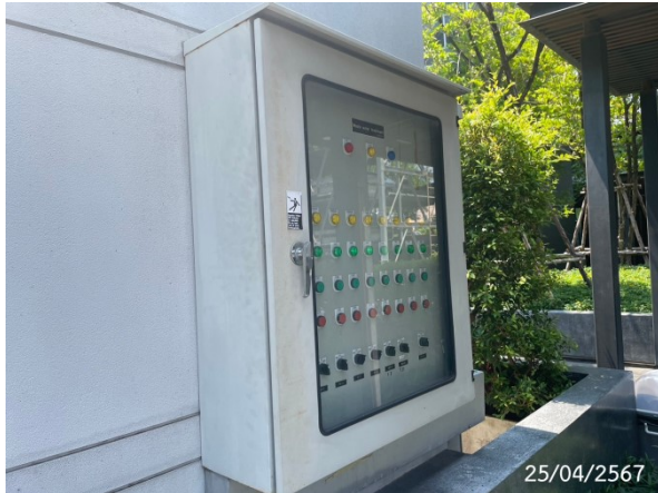
รูปที่ 2-12 ตู้ควบคุมระบบบำบัดน้ำเสียของโครงการ
