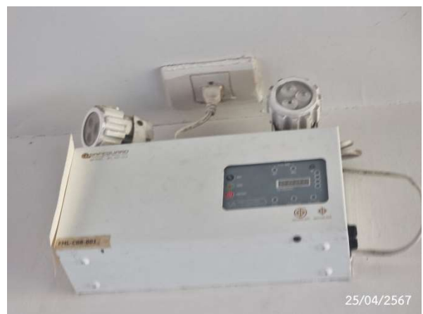
รูปที่ 2-31 ไฟฟ้าส่องสว่างฉุกเฉิน
