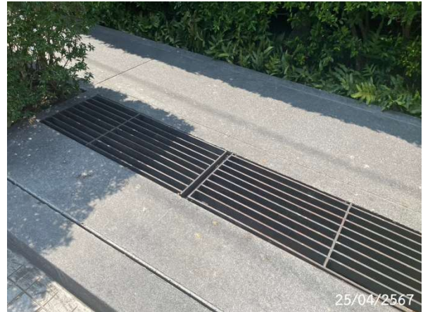
รูปที่ 2-24 บ่อพักน้ำและรางระบายน้ำของโครงการ
