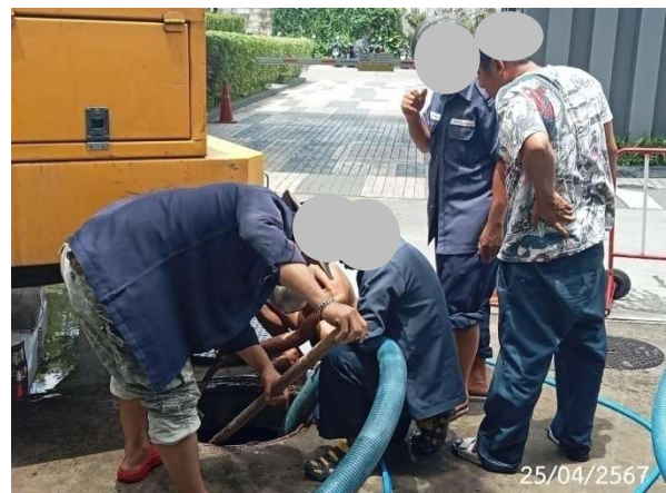
รูปที่ 2-11 เจ้าหน้าที่สูบล้างถังดักไขมันและกากตะกอนจาก ระบบบำบัดน้ำเสีย
