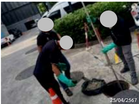
รูปที่ 2-10 เจ้าหน้าที่ตัดไขมันจากถังดักไขมัน
